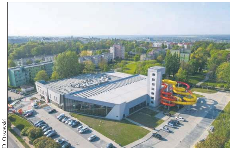
Aquapark Płock został oddany do użytku w kwietniu 2024 roku
