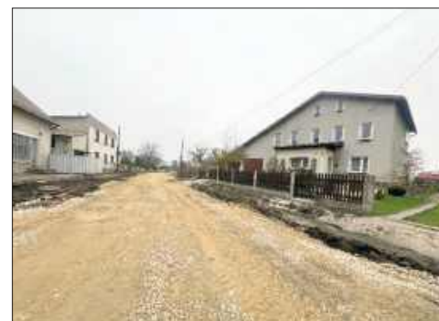
Droga ul. Raciborska w Turzu
