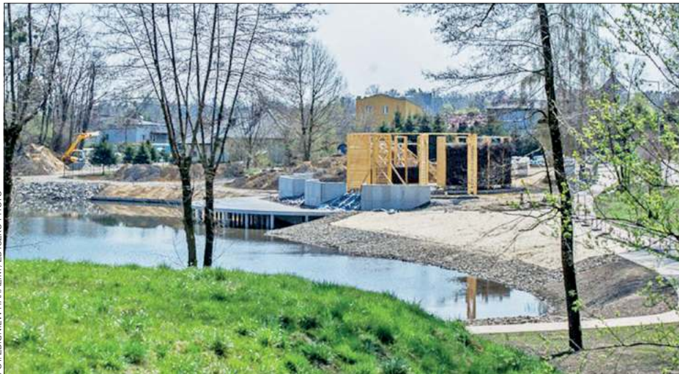
Prace przy Machnikowcu nie ustają. Na razie terminy są zachowane, jednak poziom wody ogranicza część prac.
