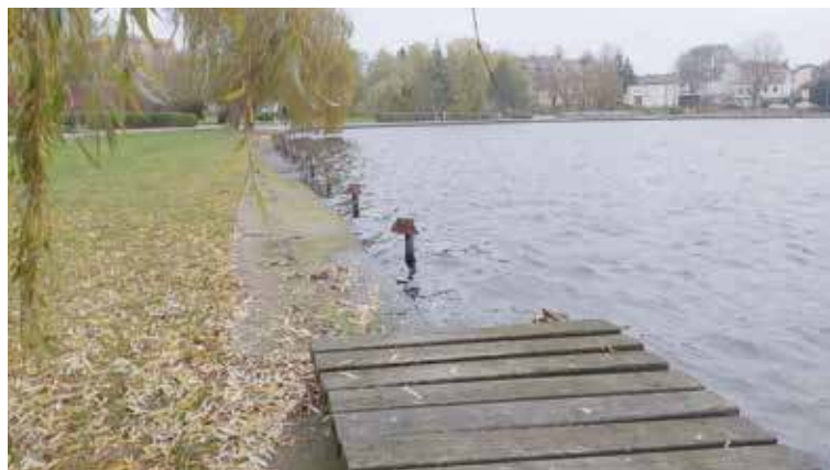
Zniszczony pomost powoli jest demontowany, ale co z nowym... Nie wiadomo
