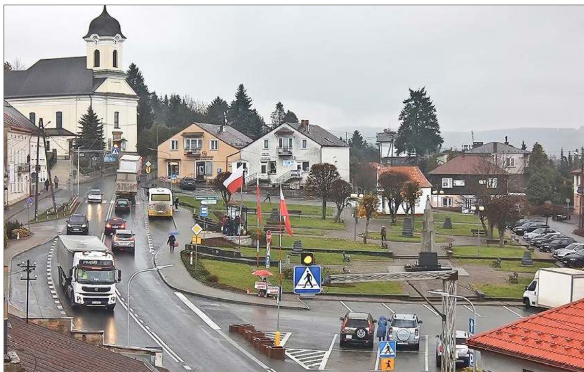
Budowa drogi pozwoli na wyprowadzenie ruchu z brzostckiego Rynku.
