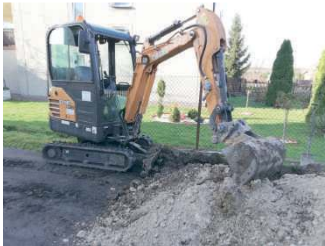
Spółka OPK w drugiej połowie 2019 roku zakupiła minikoparkę CASE CX18C. Koszt 106,5 tys. zł. Sprzęt wykorzystywany był m.in. w trakcie budowy przyłączy kanalizacyjnych w Niezdowie
