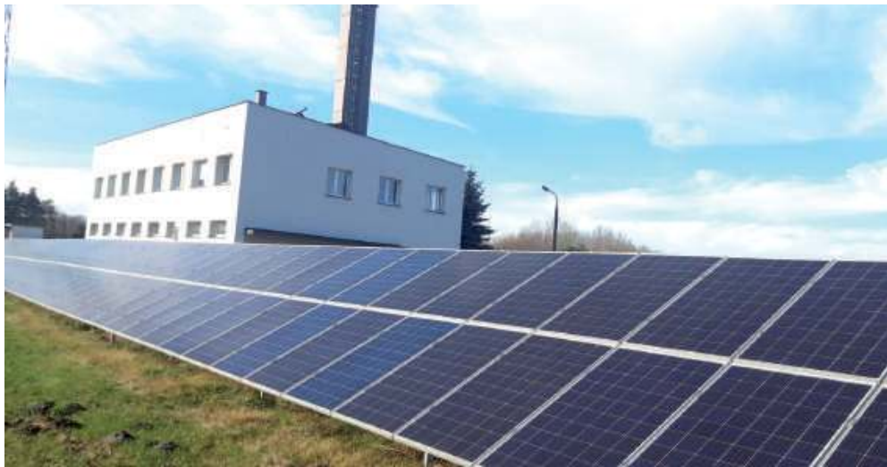
Znajdujący się na terenie oczyszczalni ścieków budynek administracyjny przeszedł w 2019 roku termomodernizację. Przy okazji przebudowane zostało zaplecze socjalne dla pracowników. Koszt - 729 tys. zł
