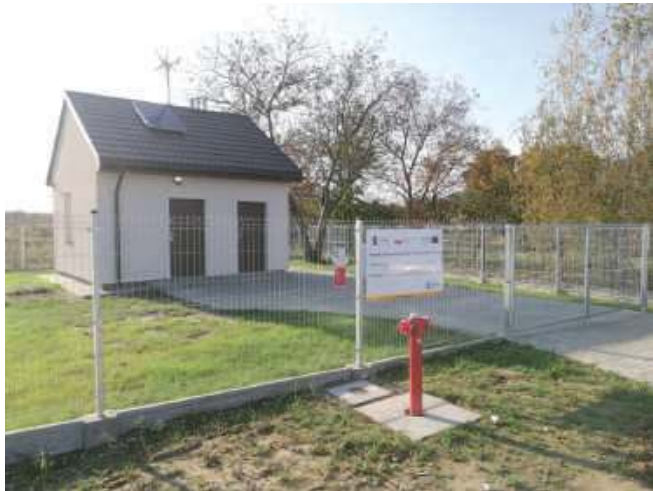
Prace przy budowie ujęcia wody w Kamionce prowadzone były w 2020 r. Dotyczyły przebudowy istniejącego budynku ujęcia wraz z uzbrojeniem terenu wokół niego oraz instalacji wyposażenia, w tym pompy, sterowanie, odcięcia od zasilania wodą z gminą Łaziska
