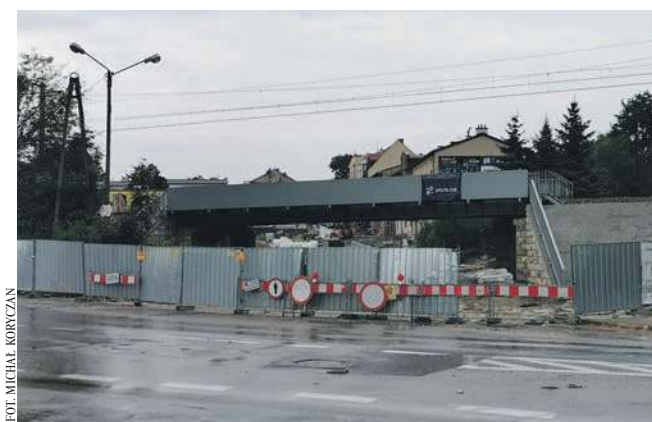
Wiadukt nad ul. Krakowską w Chrzanowie
