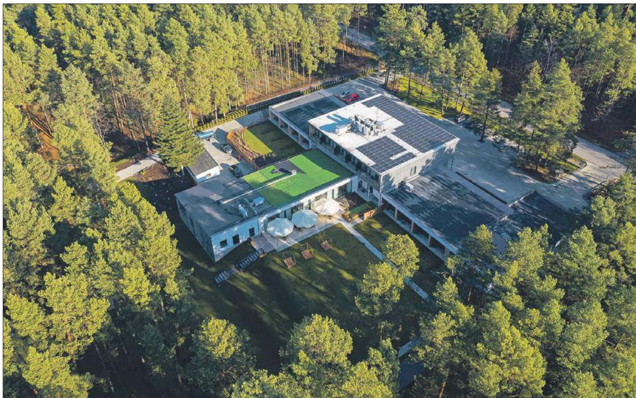
Budynek hotelu Szumy Park w Suścu po termomodernizacji
