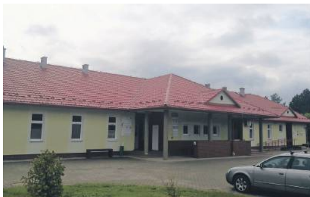
Na spotkaniu rady społecznej przychodni w Prusach rozmawiano m.in. o koniecznym remoncie schodów bocznych i podjazdu dla niepełnosprawnych
