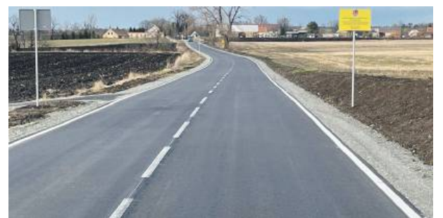
Odcinek Białobrzezie-Pożarzyce po remoncie
