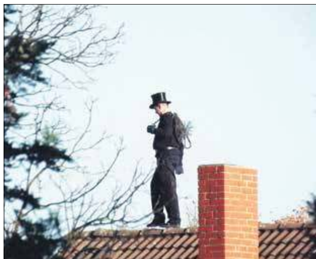
Kominy: instalację dymową, spalynową oraz wentylacyjną należy poddawać okresowej kontroli oraz czyszczeniu przez uprawnionego kominarza
