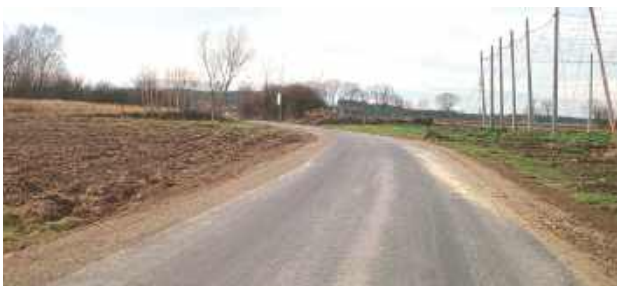
Dzięki poprawie stanu technicznego drogi zwiększyło się bezpieczeństwo jej użytkowników
