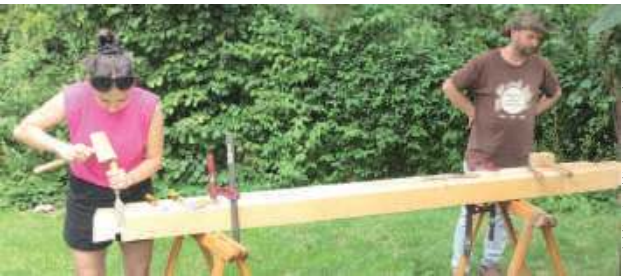
Warsztaty to przede wszystkim praktyczna obróbka ciesielska drewna, ostrzenie narzędzi i zabiegi konserwatorskie przy drewnianych elementach
