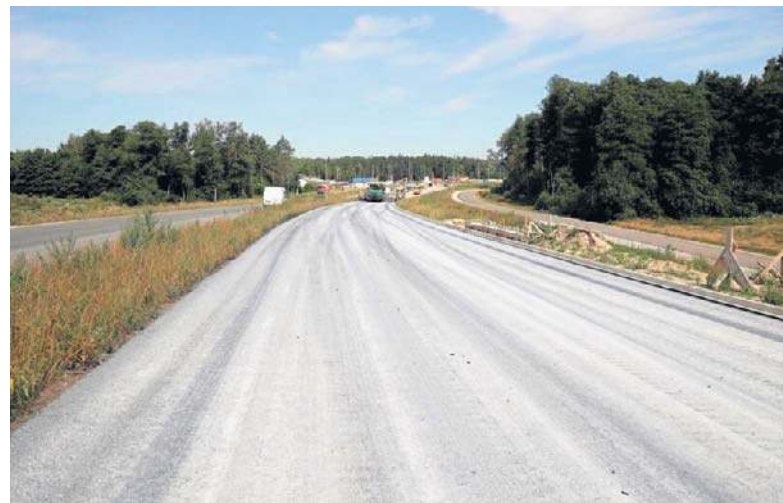
Na nowym odcinku obwodnicy Morawicy i Woli Morawickiej trwają przygotowania do ułożenia końcowej warstwy nawierzchni
