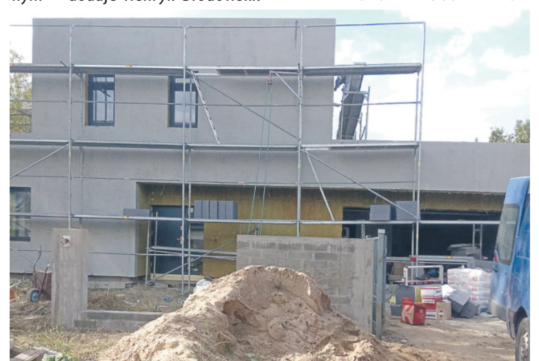
Budowa domu w Stoku Lackim
