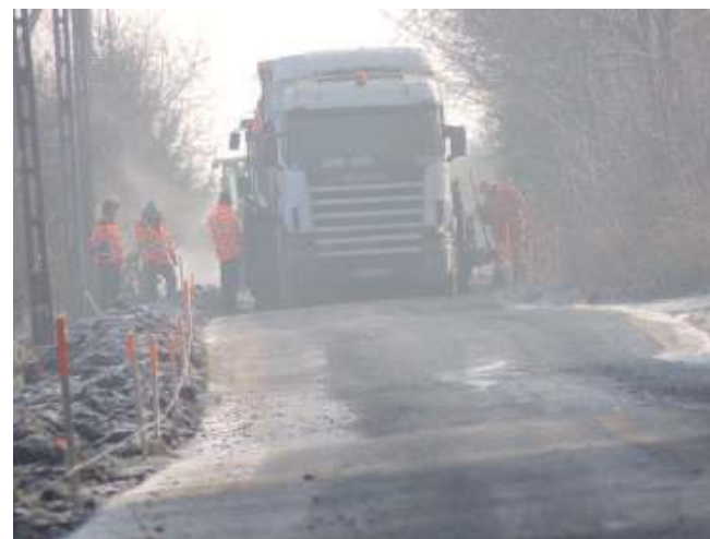
Za przebudowę 250 m odcinka drogi gminnej w Kamieniu samorząd zapłacił 65,3 tys. zł
