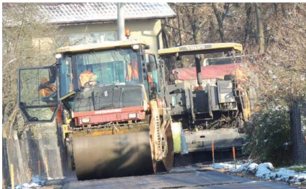
Z kolei koszt przebudowy 360 m odcinka drogi w Kamieniu sięgnął 95 tys. zł
