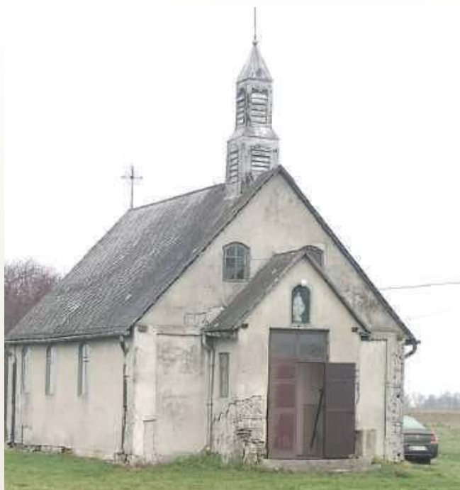
Świątynię mariawicką w Goździe (obrazek „płockiego”) znajdziemy po prawej stronie przy wyjeździe na Kłoczew. Nabożeństwa odprawiane są w I i IV niedzielę miesiąca o godz. 15
