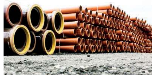
W ramach prac wybudowane zostanie około 5,5 km sieci wodociągowej
