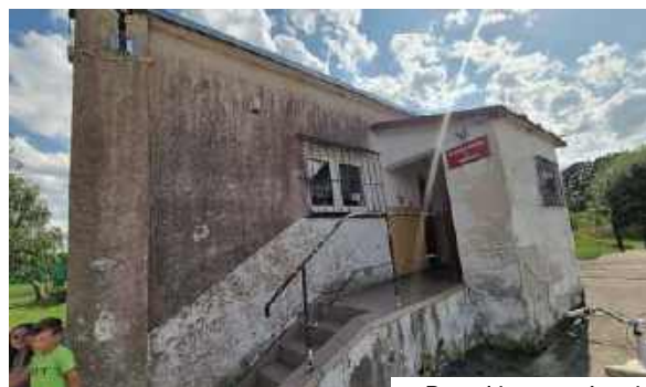
Przed i po modernizacji świetlicy w Mażanach
