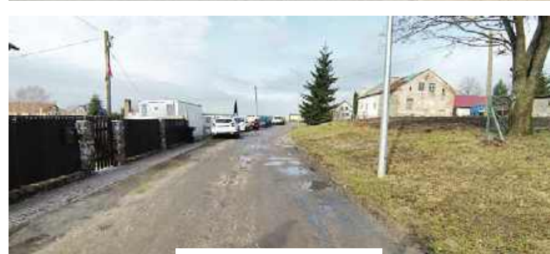
Przed i po przebudowie drogi w Nowej Różance
