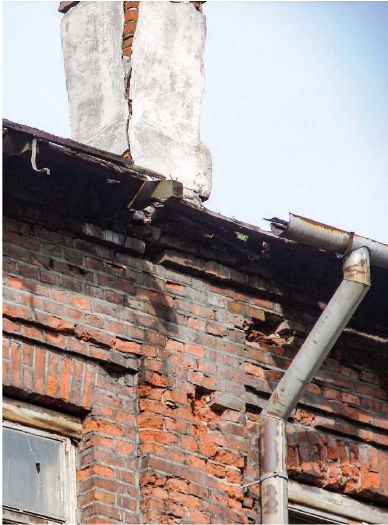
wnej i zniszczona rynna, pogłębiająca destrukcję | fot. Janusz Sujecki/Gazeta Polska
