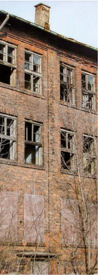
wnej i zniszczona rynna, pogłębiająca destrukcję | fot. Janusz Sujecki/Gazeta Polska
