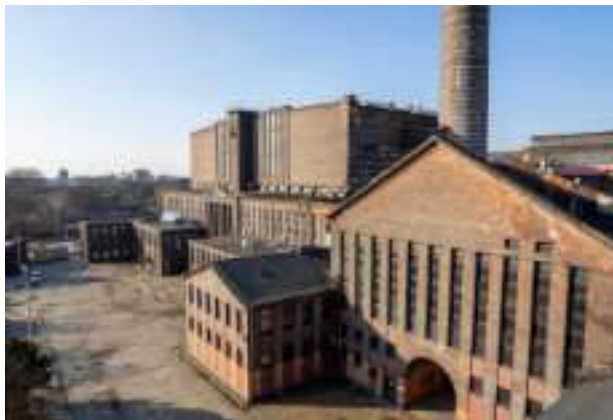
► Rewitalizacja kompleksu dawnej elektrociepłowni Fot. UM Zabrze
