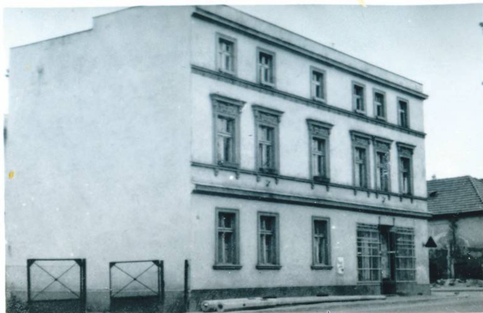
Budynek przy ul. Kutrowskiego 8 - już wyburzony
