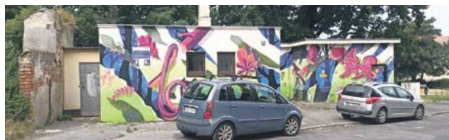
Szalet miejski będzie wyremontowany. Chodzi o dach i wnętrze
