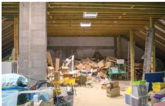
Jeszcze niezagospodarowane poddasze w szkole w Zofiówce
