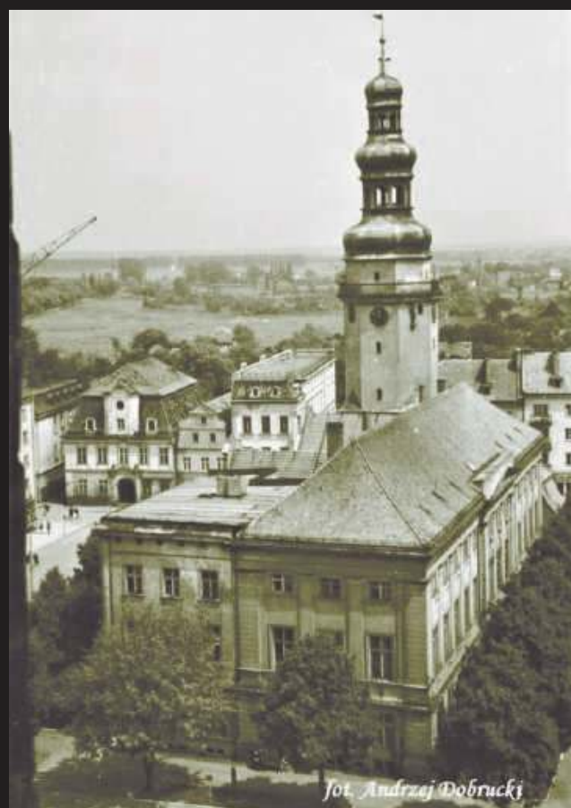
Zdjęcie wykonane z wieży kościoła Matki Boskiej Pocieszenia w 1966 roku. Na pierwszym planie ratusz z wieżą. Widać, że elewacja jeszcze jest przedwojenna. Na drugim planie po prawej budynek, w którym na parterze była restauracja Adria i kawiarnia Jola. Po lewej stronie wieży ratuszowej widać budynek, w którym przez lata na parterze i na piętrze był Wiejski Dom Towarowy. W następnym, tym małym, mieściła się cukiernia, gdzie PSS, a potem WSS Społem Olawa, produkowały ciastka, pączki i lody do 1980 roku. W następnym budynku przed wojną była apteka - jedna najstarszych na Dolnym Śląsku. W czasie wojny i bezpośrednio po wojnie była zniszczona i rozgrabiona, potem już nigdy nie została uruchomiona. Po wojnie były tu mieszkania, klub Ruchu, a po pożarze w 1967 i po odbudowie powstał Pałac Ślubów, czyli obecnie Urząd Stanu Cywilnego. Z tyłu po prawej, za wieżą, widać budynki przy ul. Rybackiej od mostu w lewo, a wcześniej widzimy ogrody. Po lewej są zabudowania rzeźni miejskiej, które stoją do dziś. Widzimy też ulicę Sportową, wtedy wysadzaną akacjami, a na środku są łąki - dziś tu jest Osiedle Bolesława Chrobrego
