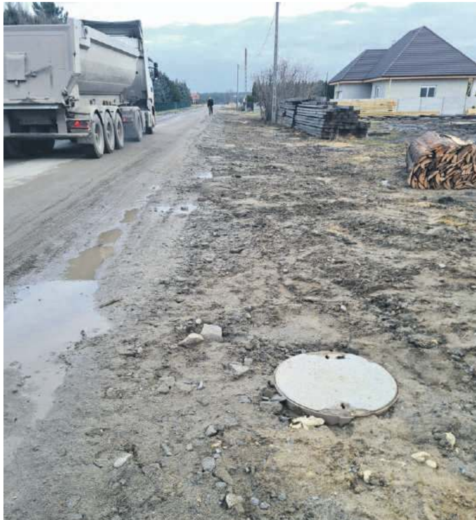
Przy ul. Wójcickiej w Bystrzycy trwa rozbudowa kanalizacji, ale sposób wykonywanych prac budzi pytania i wątpliwości mieszkańców. - Gdzie jest rów? - pytają
