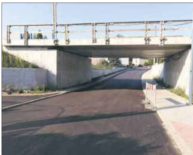
Po ponad 2 latach ul. Chocimska jest wreszcie przejezdna
