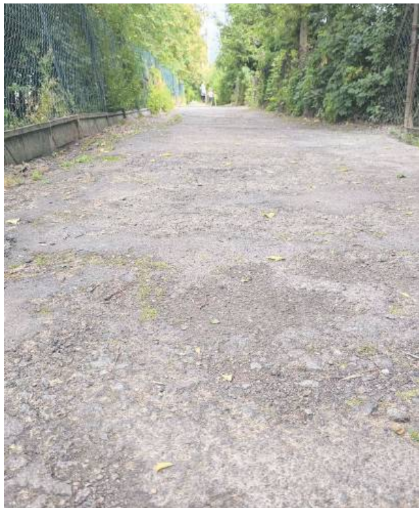
Dziura na dziurze i potykanie się o nierówności to dotąd codzienna rzeczywistość dla poruszających się odcinkiem drogi od urzędu do szkoły w Przewornie. Najpóźniej z nadejściem nowego roku szkolnego 2024/25 ma to się zmienić. Droga zostanie zmodernizowana
