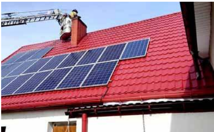
Strażacy gasili pożar sadzy w przewodzie kominowym w miejscowości Gronówko. Foto OSP Dobrzany
