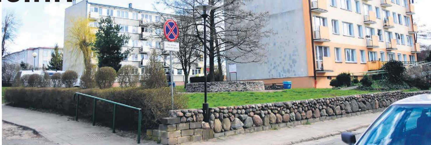
Jakie prace remontowe będą realizowane w tym roku na terenie spółdzielni?
