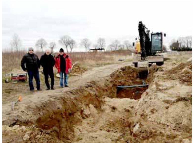
Modernizacja oczyszczalni w Chociwlu z dofinansowaniem w kwocie 3 mln 600 tys.
