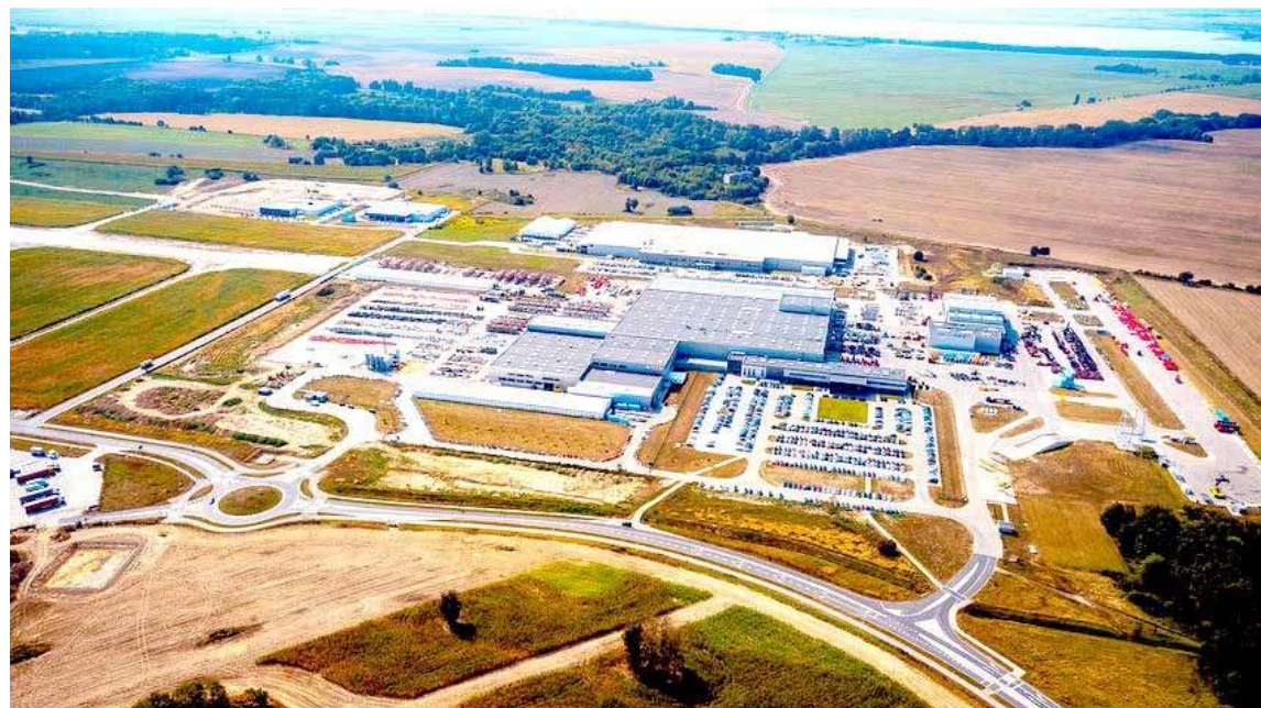
Pierwszy etap uzbrojenia Parku Przemysłowego Nowoczesnych Technologii otrzymał dofinansowanie w wysokości 3 739 755 zł
