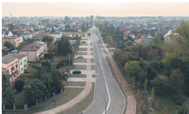
Dzięki projektowi na Radziwie wybudowano cztery ulice
