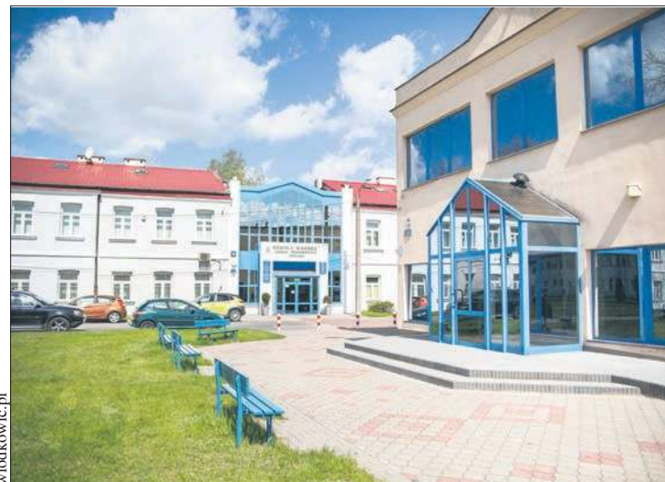
Zakończył się remont prawego skrzydła budynku A
