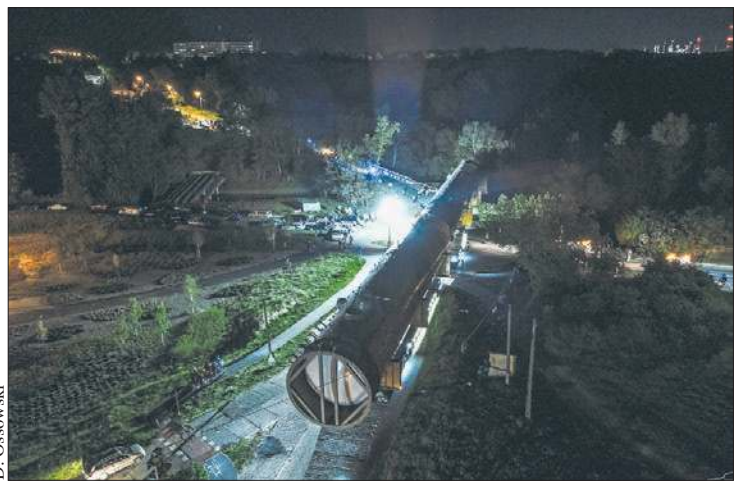
Transport kolumny Wash Tower płockimi ulicami był nie lada wyzwaniem
