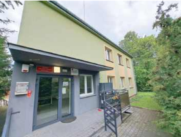
Tak budynek wygląda teraz
