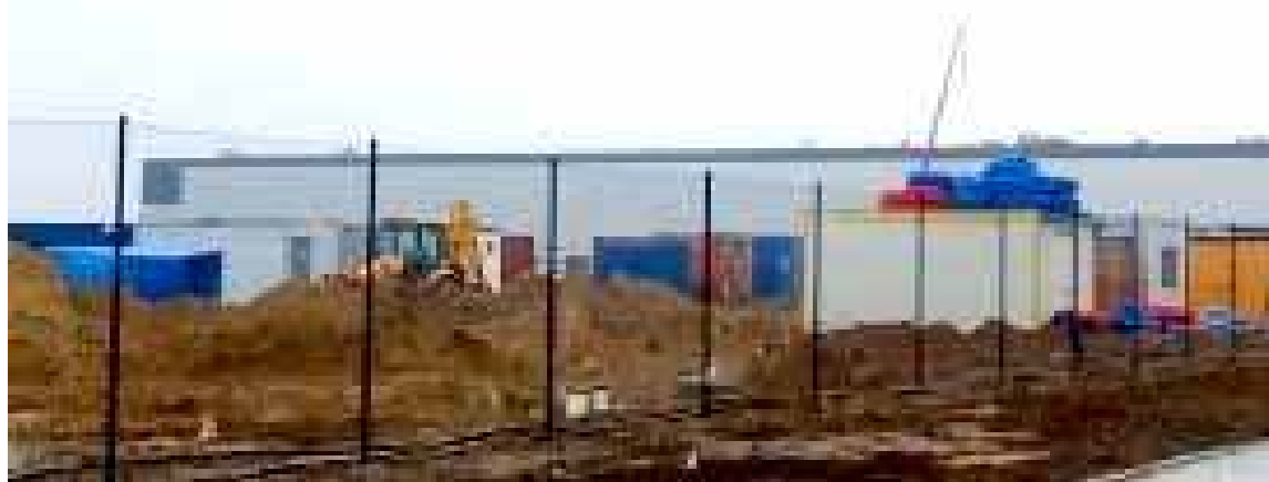
Trwa budowa pierwszej hali magazynowej Waimea Logistic. Docelowo ma powstać sześć hal
