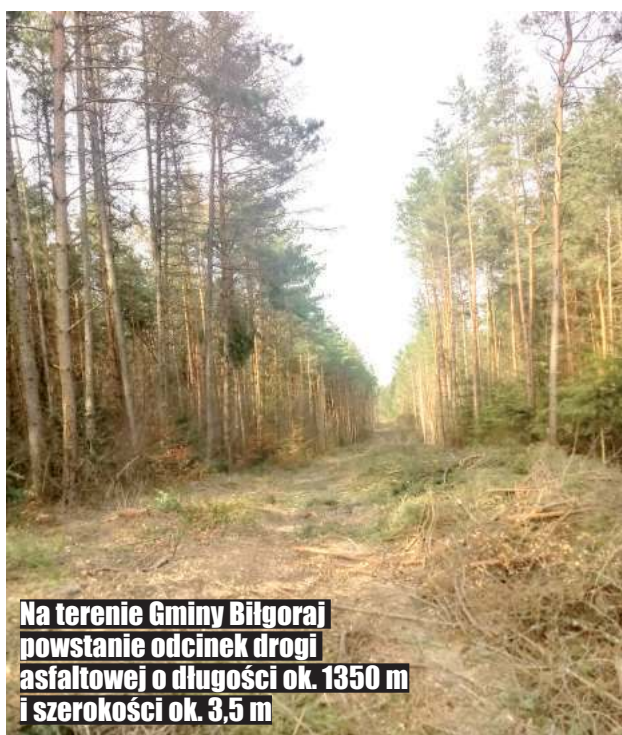
Planowany koniec budowy drogi relacji Żelebsko - Trzęsiny to grudzień 2023 r.
