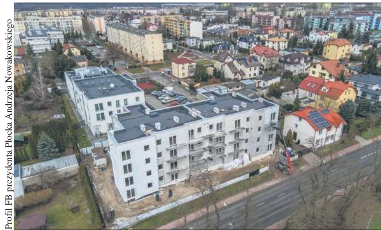
Przy ulicy Polnej 25 powstaje kolejny blok z „Mieszkaniem na start”
