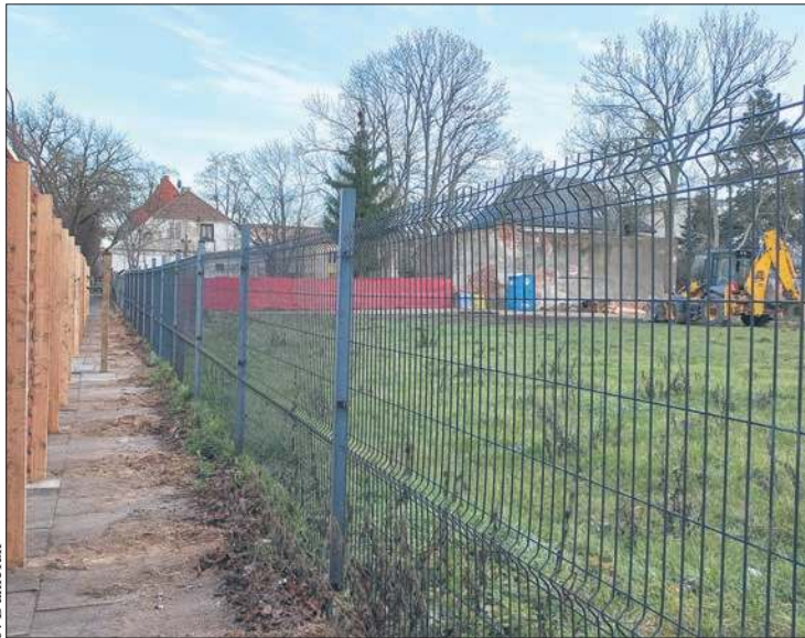
Rozpoczęły się pierwsze prace związane z budową budynku z mieszkaniami dla seniorów przy ul. Sienkiewicza 21
