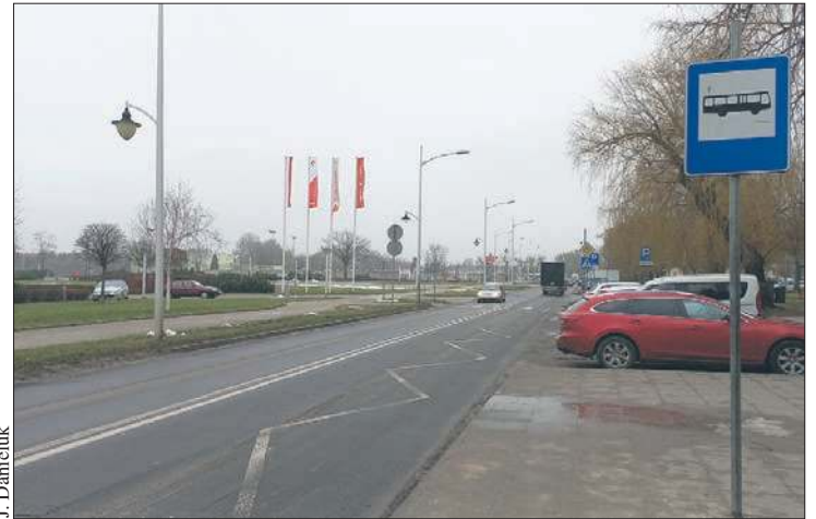
W ubiegłym tygodniu rozpoczęła się przebudowa ulicy Batalionów Chłopskich
