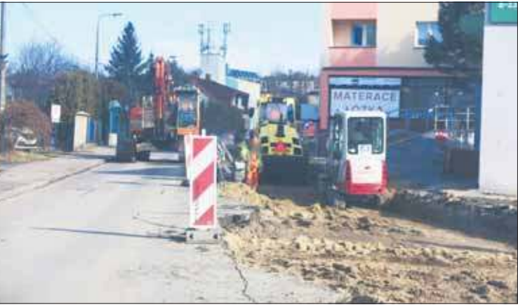
Kompleksowo wyremontowanych zostanie 685 m ulicy
