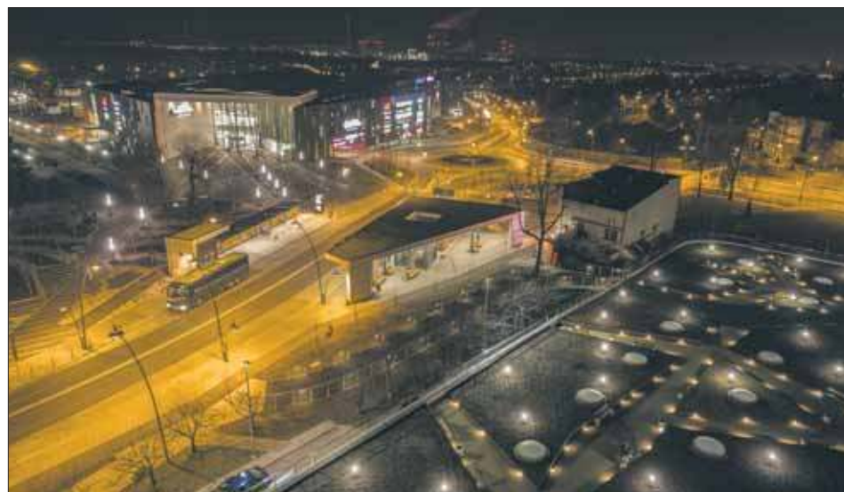
Galeria, parking i przystanki
