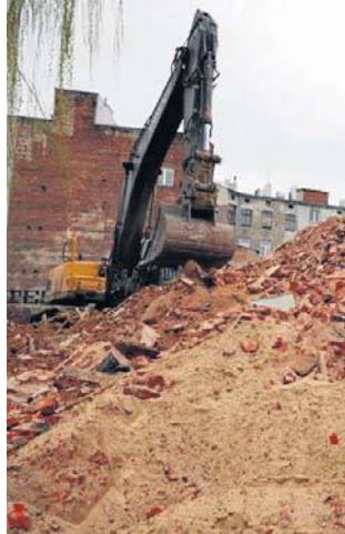
Rozbiórka kamienicy przy ul. Zachodniej
