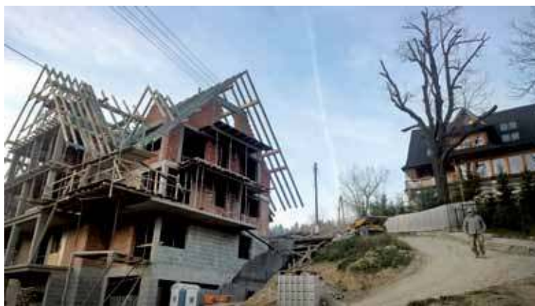
W apartamentowcu pod linią elektroenergetyczną będzie 20 mieszkań. Właściciele domu po prawej stronie musieli zmienić plany, żeby zachować odległość 50 metrów od linii elektroenergetycznej.
