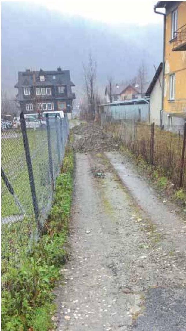
Tak w poniedziałek wyglądała droga do miejskiego budynku, w którym mieszkają między innymi starsi, schorowani ludzie.
