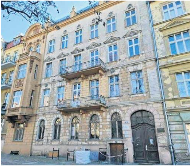
Za sprawą miejskiej dotacji blask odzyska elewacja kamienicy, ale także stolarka na klatce schodowej
