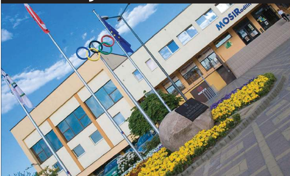
Budynek MOSiR w Radlinie przejdzie gruntowną modernizację
