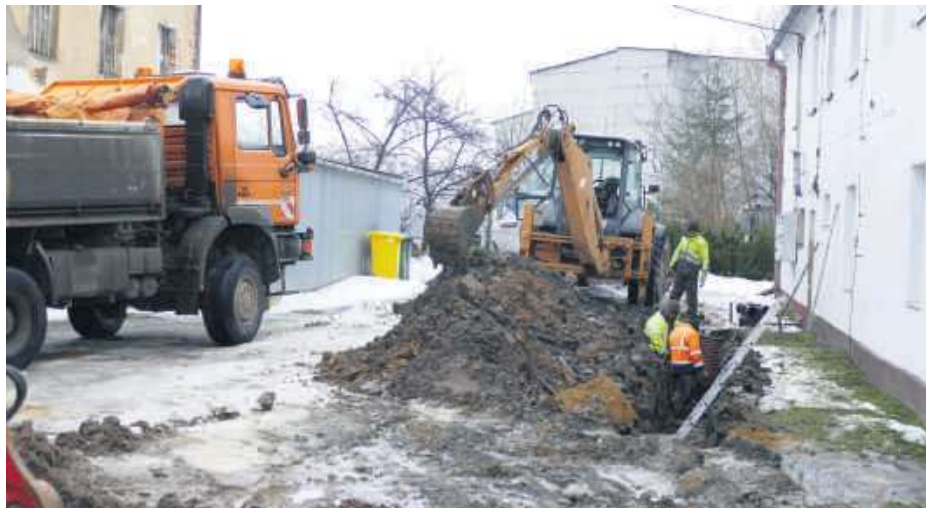
Pracownicy ZUK-u Przeworno wykonali nowe przyłącze do bloku „na młynie”
