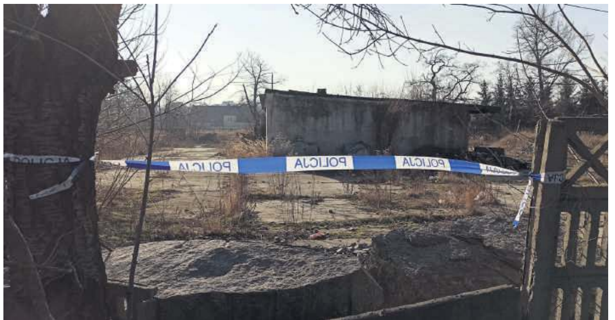
Wejście na teren po pożarze policjanci zabezpieczyli taśmą
