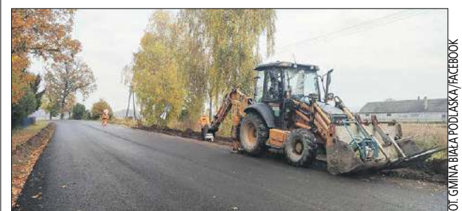
Po zakończeniu obu inwestycji mieszkańcy skorzystają łącznie z blisko 20 km nowej nawierzchni
