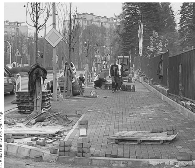
Budowa chodnika przy ul. Kętrzyńskiego w Olsztynie
