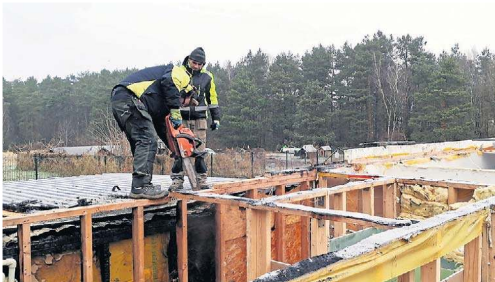
Odbudowa już trwa. Rozebrano zniszczony dach i stropy, powstaje nowa więźba dachowa
