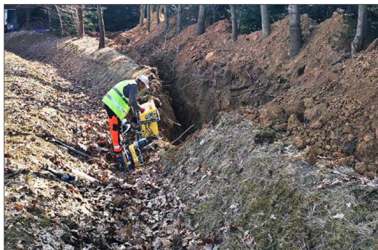
Budowa wodociągu dla Dzwonowej, Zagórza i Dęborzyna trwa.
