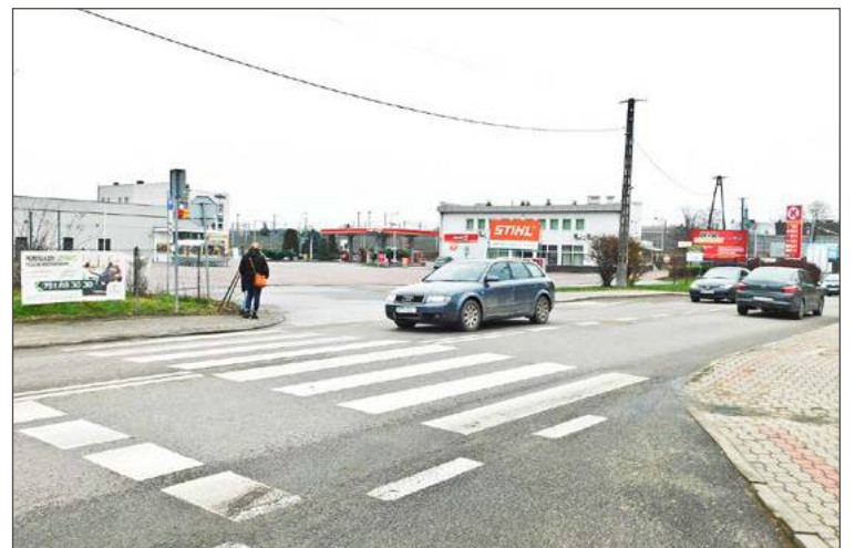
To przejście dla pieszych zakwalifikowane zostało jako niebezpieczne.
