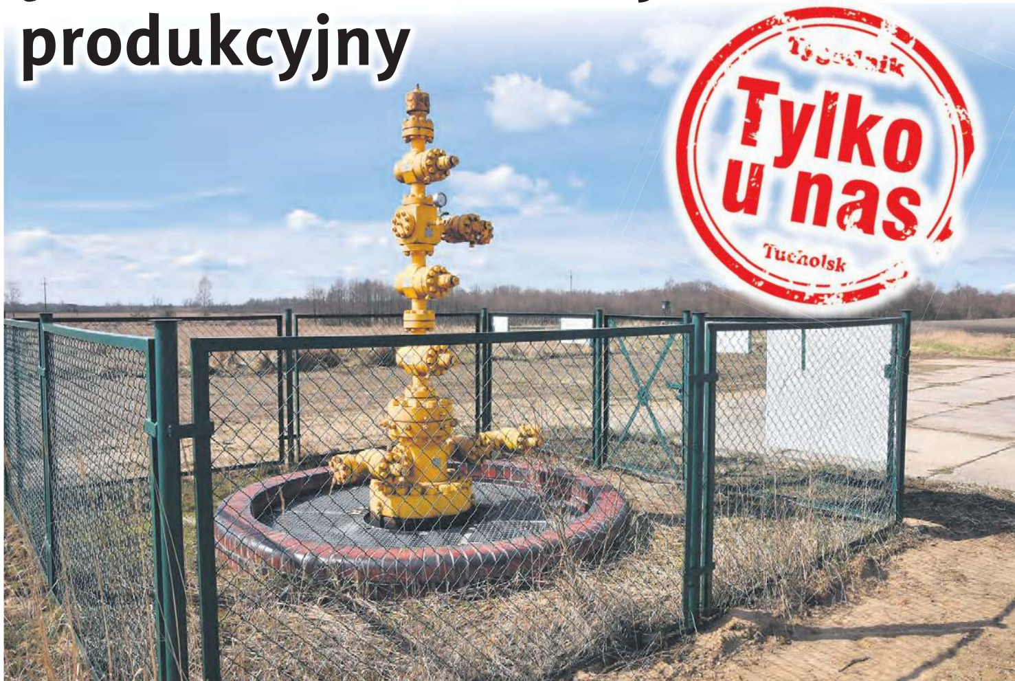
Wiertnia Tuchola 3 (Sicin) na razie wygląda tak. Do obiektu prowadzi betonowa droga, wysoka rura – otoczona z każdej strony rozległymi polami uprawnymi – widoczna jest z daleka. Jak zapowiada Orlen Upstream, jeszcze w tym roku ma tu powstać Ośrodek Produkcyjny Tuchola. Przekazanie wykonawcy terenu pod budowę nastąpi w najbliższych dniach.
