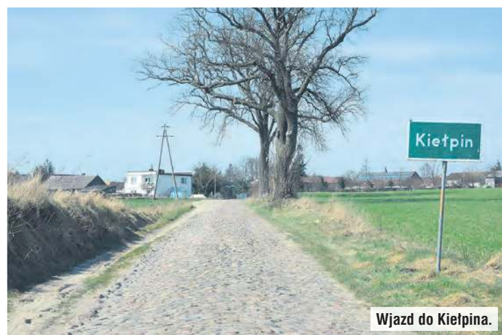
Wyrównana część drogi.
