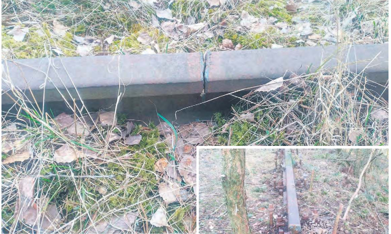
Przecięty element gotowy do rozbiórki.
