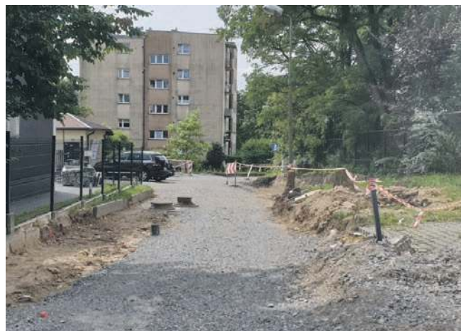
Trwa remont drogi na os. Północ w Chrzanowie
