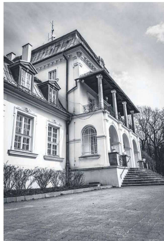
Piętrowa loggia w centralnej części elewacji budynku
