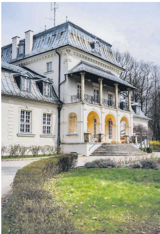
Piętrowa loggia w centralnej części elewacji budynku
