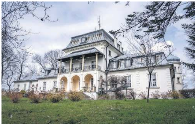
Widok od strony frontowej
