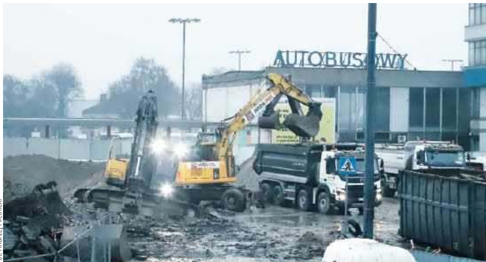
Rozbiórka dworca PKP już się kończy
