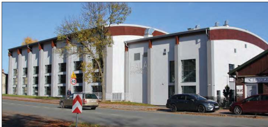
➤ Póki co na ścianie od ulicy Warszawskiej wisi napis „Hala Sportowa”, poniżej ma pojawić się imię patrona nowo wybudowanego obiektu w Rykach
