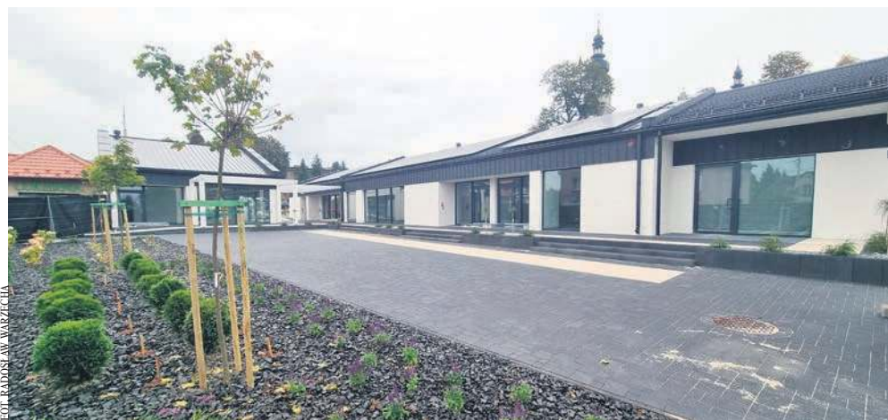
Odnowiona część handlowa placu Mogielnickiego
