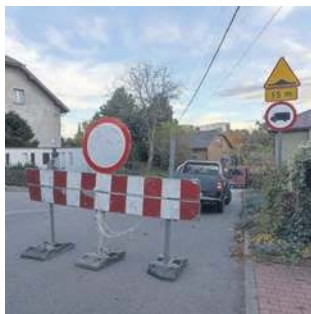
Remontowany odcinek jest obecnie nieprzejezdny
