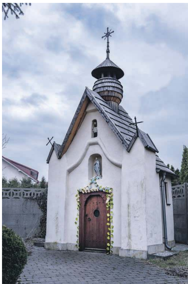
Frontowa elewacja kapliczki
