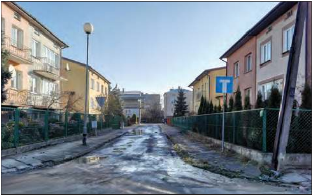
➤ Ulica Staszica przed i po modernizacji
