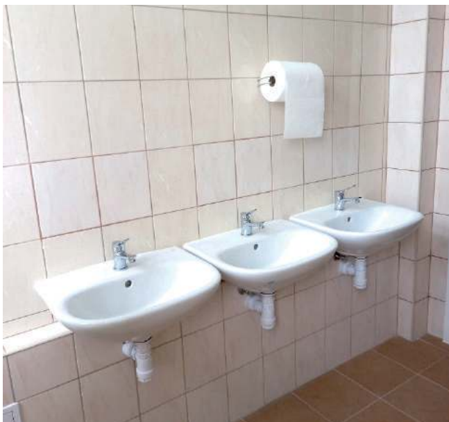
Budowlańcy zdemontowali stare sprzęty, skuli płytki, wyrównali ściany i podłogi, by położyć na nich nową glazurę i terakotę
