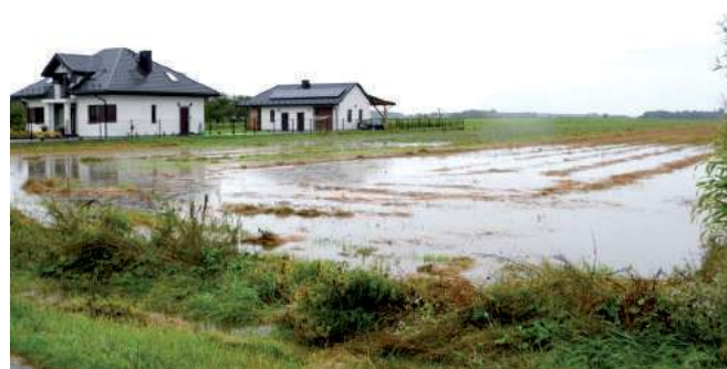
Tak prezentowały się tereny Polesia w zeszły wtorek. Woda podchodziła pod zabudowania. Strażacy mieli pełne ręce roboty, odpompowując wodę z poszczególnych pól. Niebawem ma tu zostać wybudowany przepust
