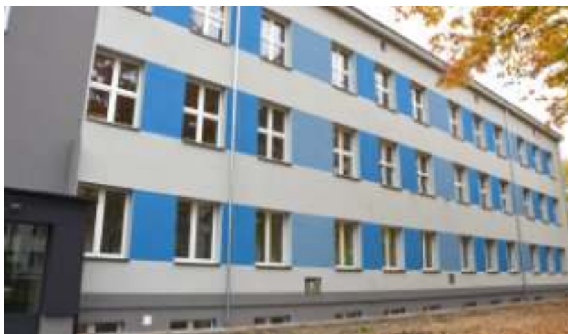
► Wyremontowany budynek szkoły Fot. UM Zabrze
